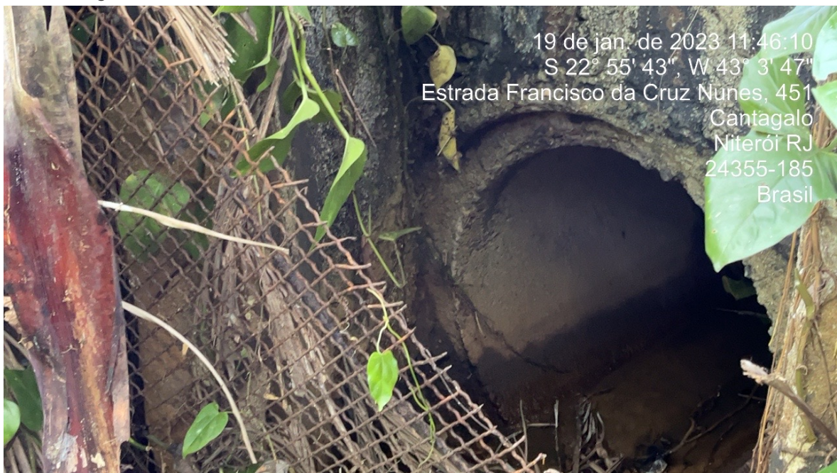
Figura 14 - Vista do início do trecho da Intervenção 5 com manilha de 800 mm.
