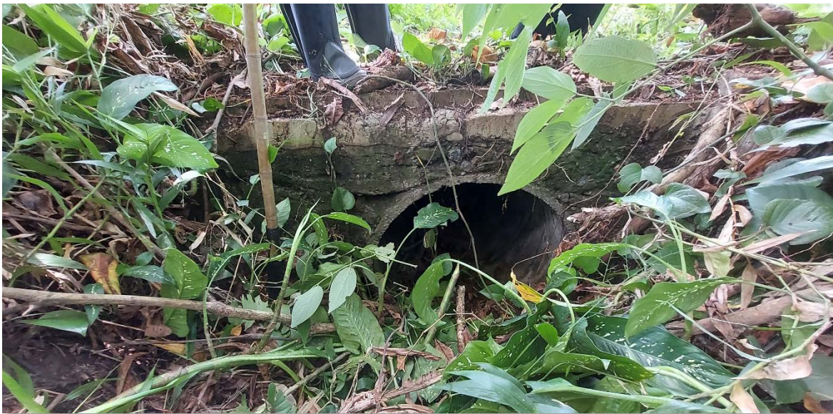
Figura 11 - Vista da entrada da manilha de 800 mm do trecho de canalização seco.
