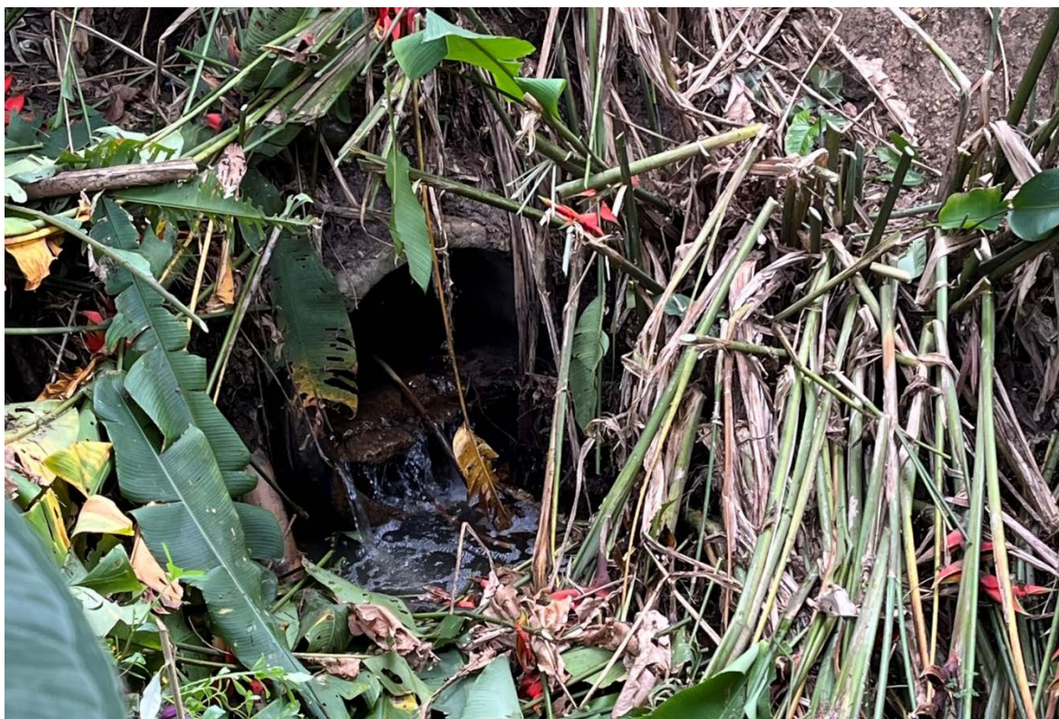
Figura 9 - Detalhe aproximado da manilha desta canalização, com manilha de concreto de 800 mm.
