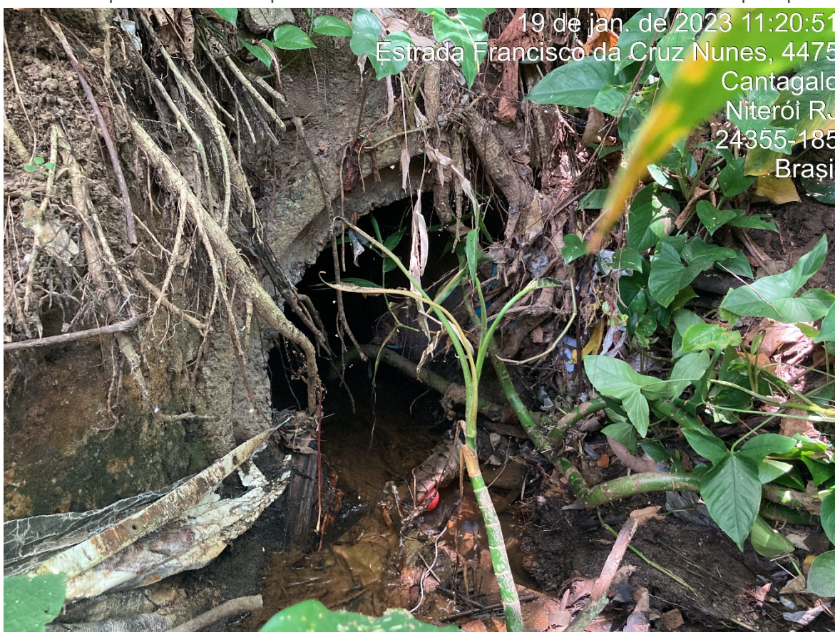
Figura 10 - Vista da entrada da manilha de 800 mm por onde o afluente do Rio Arrozal segue canalizado por um trecho de aproximadamente 22 metros até a confluência com o rio principal.
